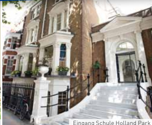
Eingang Schule Holland Park
