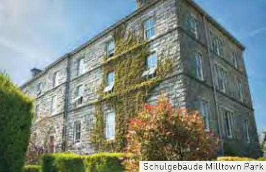
Schulgebäude Milltown Park
